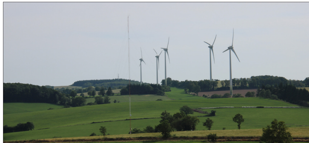
Parc éolien de Lestrade-et-Thouels Source : Artifex 2019
